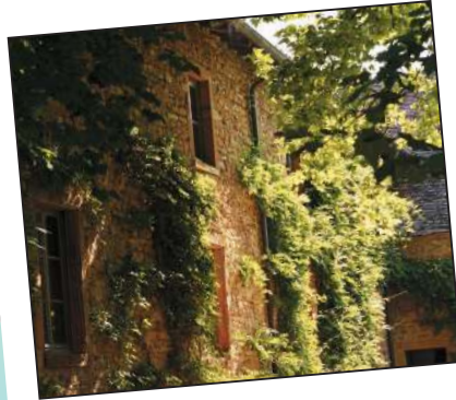
2 Dans une maison
