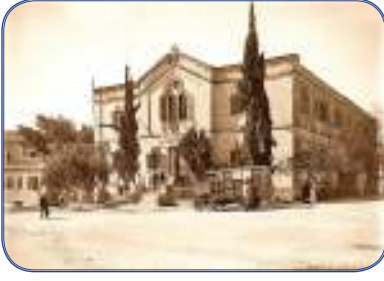
جزء من مبنى مجمع المسكوبية
