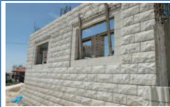
البناء بالحجر الصخري اثناء الإنشاء
